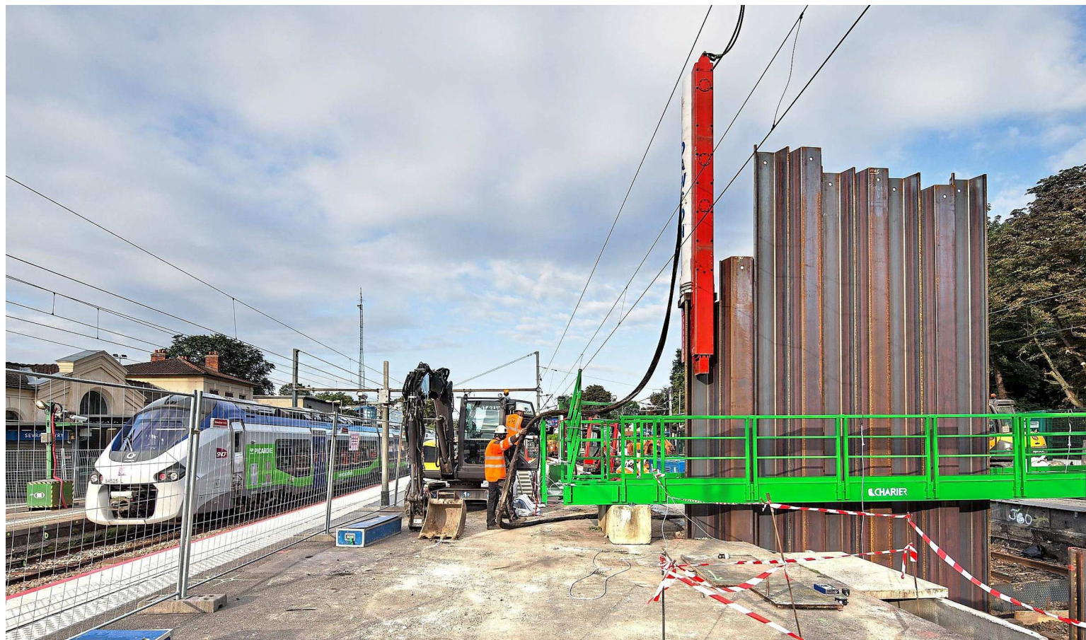
Sevran (Seine-Saint-Denis), Les chantiers du Grand Paris Express vont produire 50 millions de tonnes de remblais. DR
